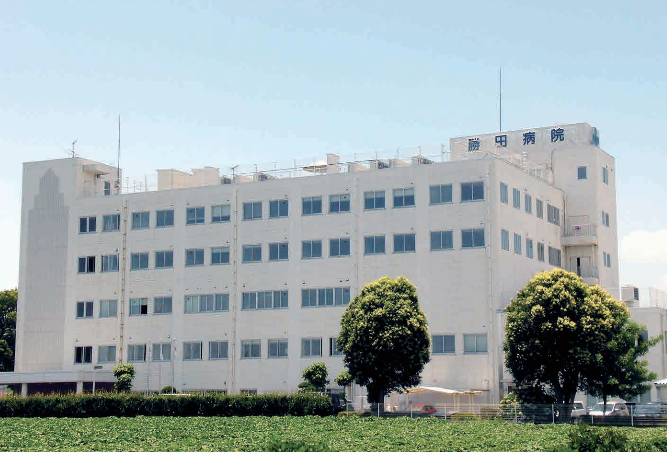
●勝田病院外観
