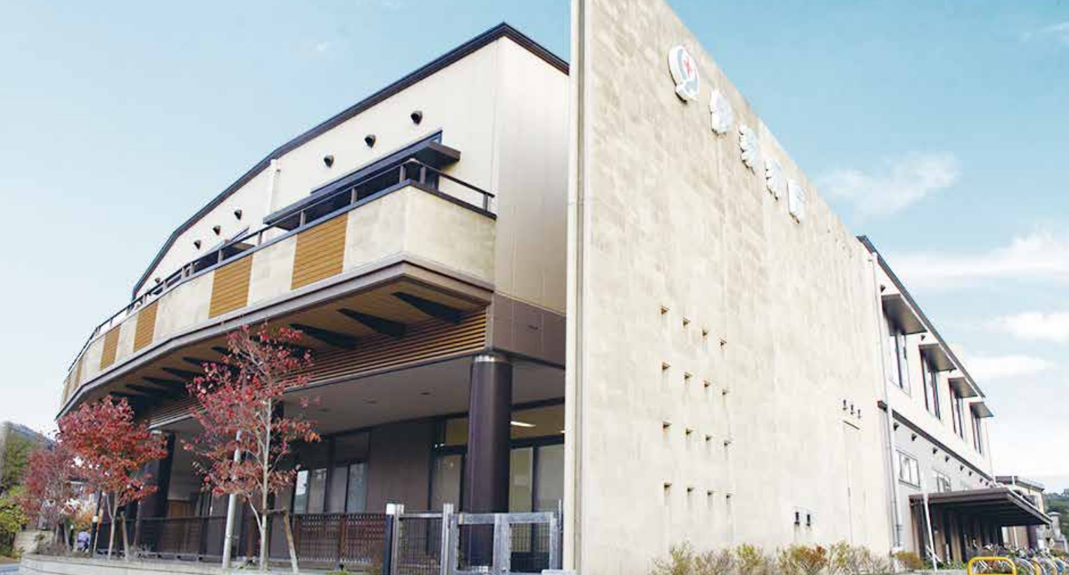
●伊奈病院外観
